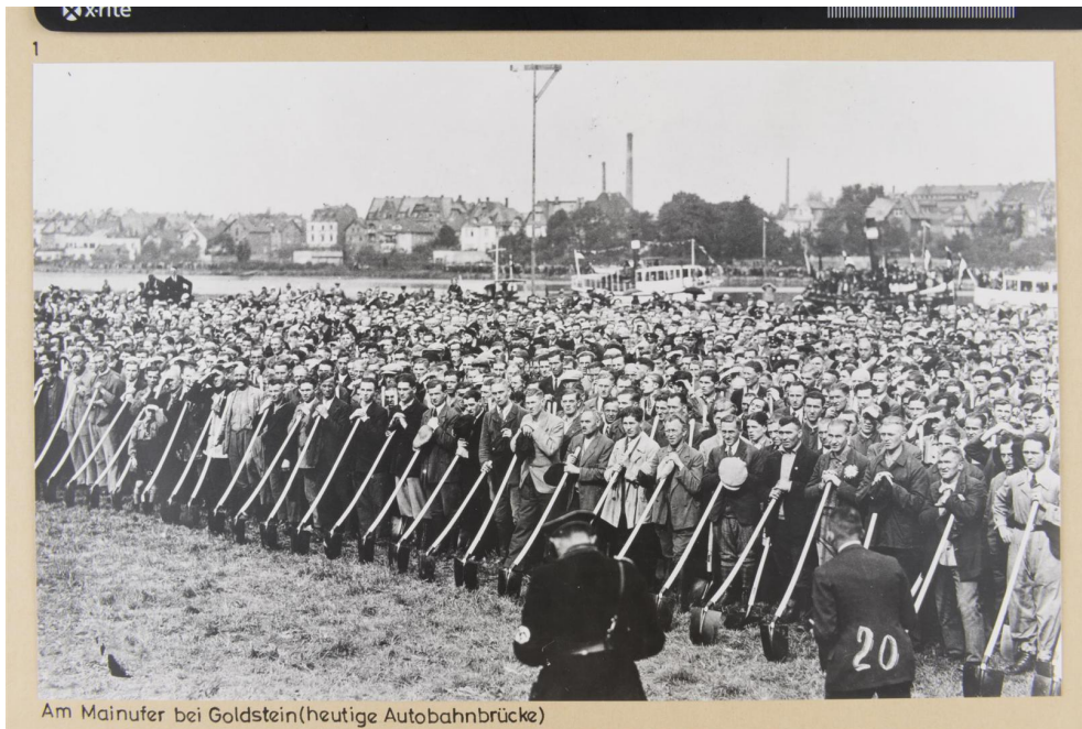
Am Mainufer bei Goldstein (heutige Autobahnbrücke)
